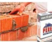
**M-150** – универсальная смесь на цементно-известковой основе с пластифицирующими добавками. Для кладки стен и перегородок из кирпича для наружных и внутренних работ.
