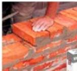
**M-150 и M-300** – применяется для кладки стен и перегородок из кирпича и других элементов, для наружных и внутренних работ.
