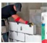
**Blokus** – сверхпластичная клеевая смесь для монтажа блоков и плит из ячеистого бетона, газосиликата и газобетона. Исключает появление «мостиков холода» благодаря шву 2-5 мм.
