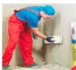
**TermoRob** – облегченная цементная штукатурная смесь с перлитом. Для выравнивания стен на фасаде и внутри зданий.
