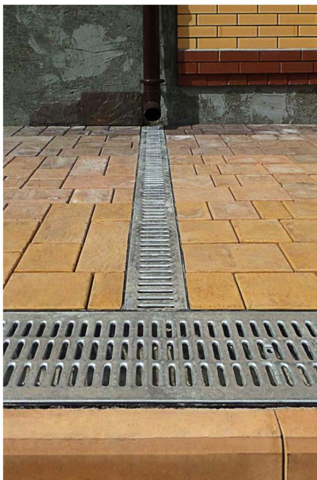
Частный дом, водоотводные лотки Hidrolica® Standart с оцинкованными решетками
