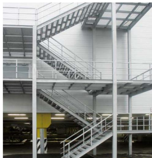
Использование ступеней из ячеистых решеток делают открытые лестницы безопасными в осенне-зимний сезон.
