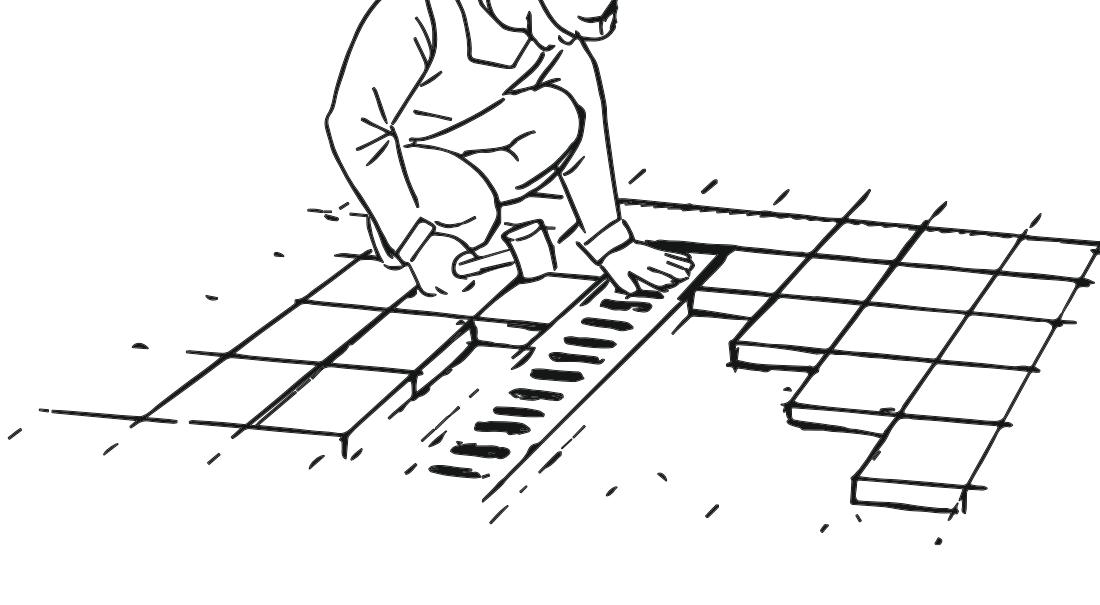
13. Герметизация паза технологического шва между лотком и примыкающей конструкции.
