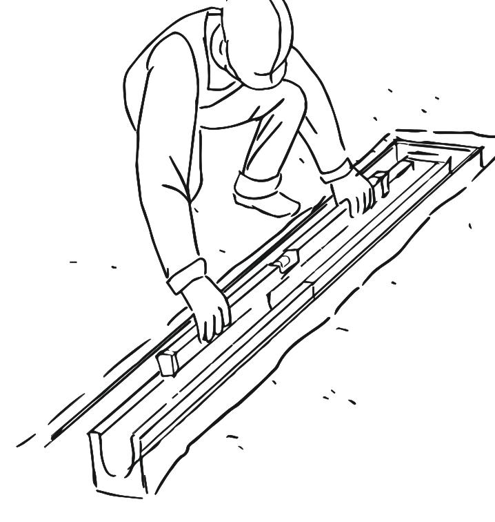
8. Установка крепежей в лоток как элемента распорки при заливки боковых граней бетонной обоймы.
