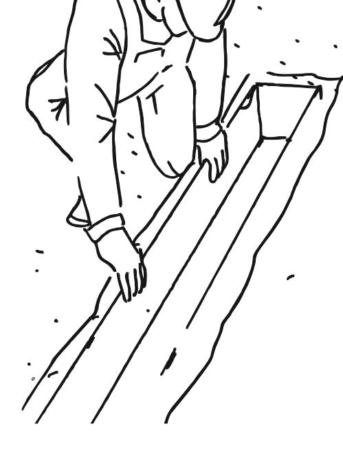
5. Заливка бетонной смесью **B25** нижней части бетонной обоймы **150 мм**.
