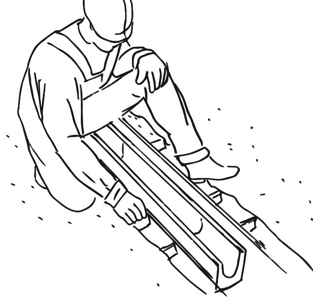
7. Выставление лотка по уровню на бетонном основании с дополнительной смесью бетона и герметизация паза между лотками.
