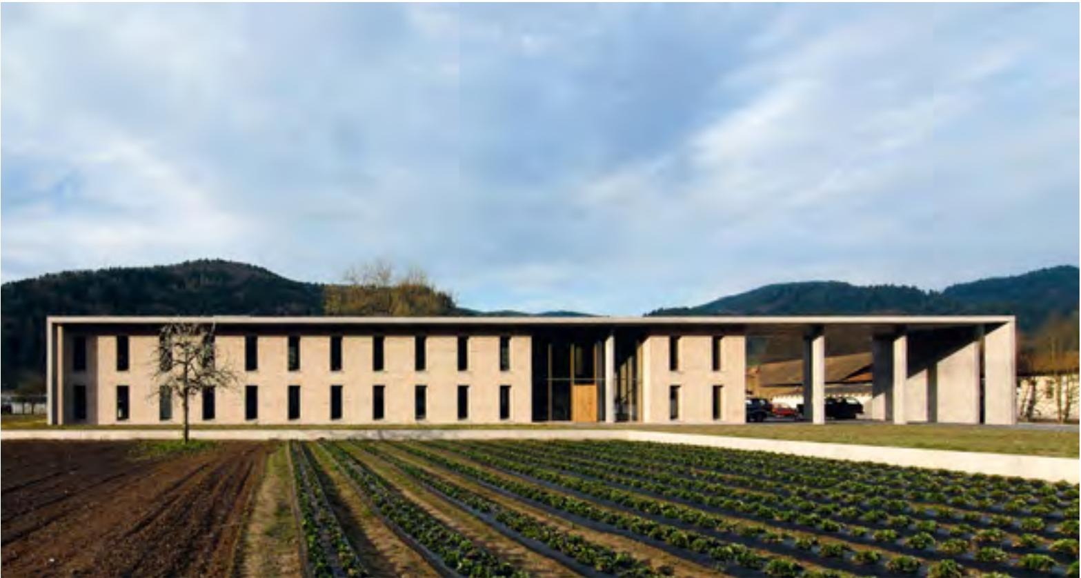
▲ Das durchgängige Sichtbetondach umrahmt das Bürogebäude und bildet eine Torsituation.
