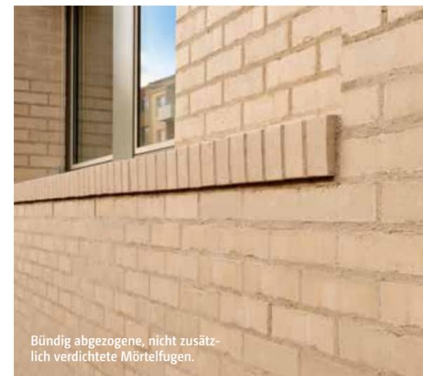
Bündig abgezogene, nicht zusätzlich verdichtete Mörtelfugen.
