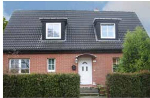
Das zuvor unscheinbare Häuschen (kleines Foto) wurde mit buntweißen Rößen GEESTBRAND Handform-Riemchen auf einem WDVS in ein Schmuckstück verwandelt – mit neuem Tondach, neuer Riemchen-Fassade und neuer Gartenmauer.
