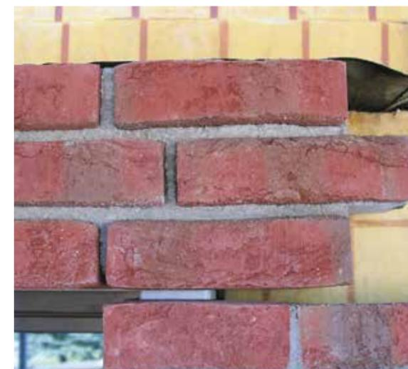
Läufersturz mit direktem Auflager und Verzahnung im Mauerwerksverband.
