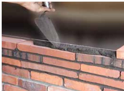
Четкий утопленный шов получается при заделке швов с помощью расширочного инструмента.
