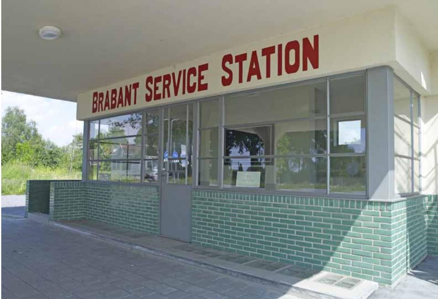
Глазурованный кирпич (ручной формовки vormbak) для проекта реконструкции в стиле новый объективизм, заправка в г. Хертогенбос
